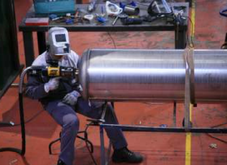
Intercambiadores de calor
